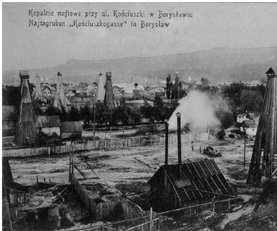
Kopalnie naftowe przy Kościuszkogasse w Borysławiu.
